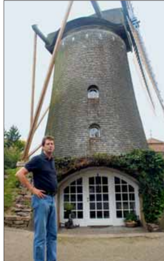
Die Veerter Windmühle wurde um 1865, in der Hochzeit des Windmühlenbaus, aus Backsteinen gebaut und war bis 1943 in Betrieb. Um die Mauern trocken zu bekommen, wurde sie um 1972 mit Zedernholz-Schindeln verkleidet.
